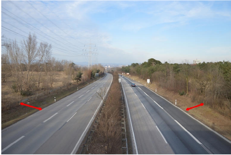
Blick auf die A 643 von der Fußgängerbrücke im Mainzer Sand aus. Die roten Pfeile zeigen, wie weit die ausgebaute Autobahn reichen würde - Foto: gik
